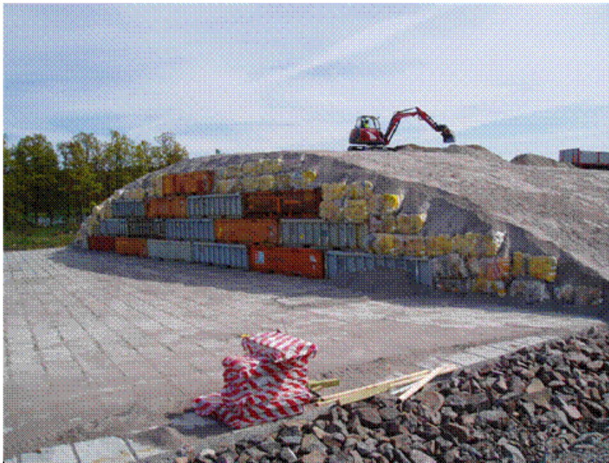
3.13 pav. Išlyginamojo sluoksnio formavimas
