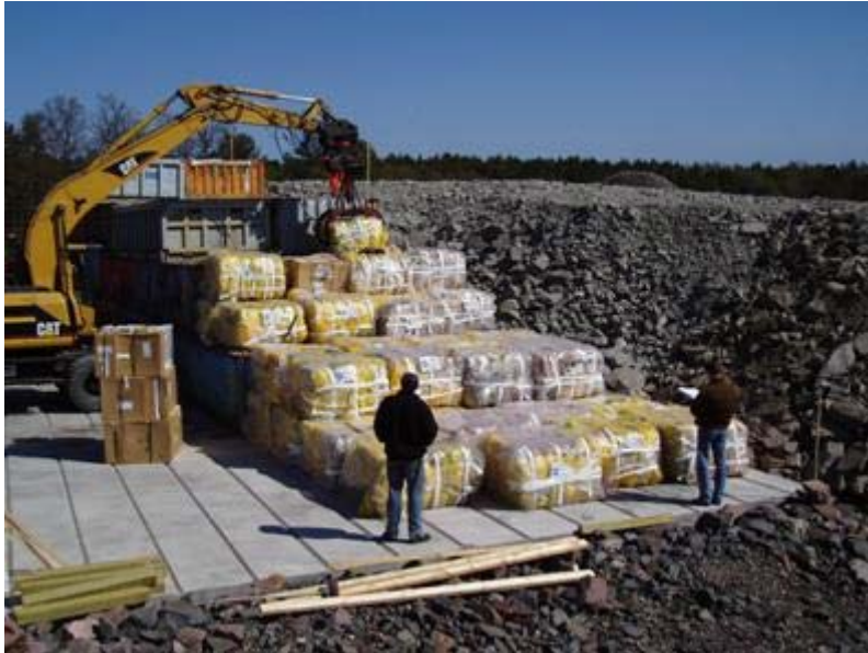
3.11 pav. Paketų ir plastikinių konteinerių iškrovimas ir statymas
