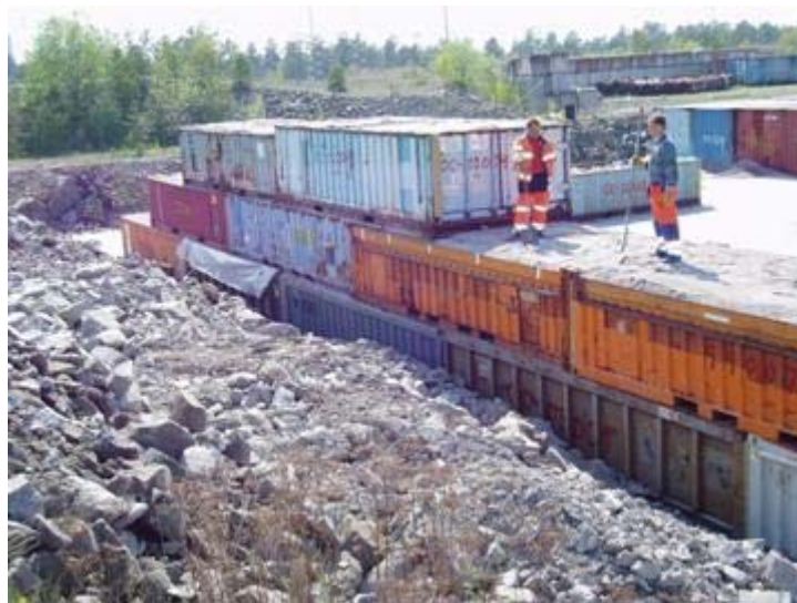
3.12 pav. Tuščios erdvės tarp konteinerių užpildymas
