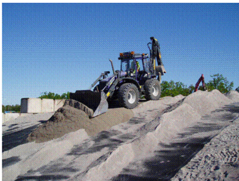
3.16 pav. Drenažinio žvyro sluoksnio formavimas, geotekstilės klojimas, gamtinės medžiagos sluoksnio formavimas
