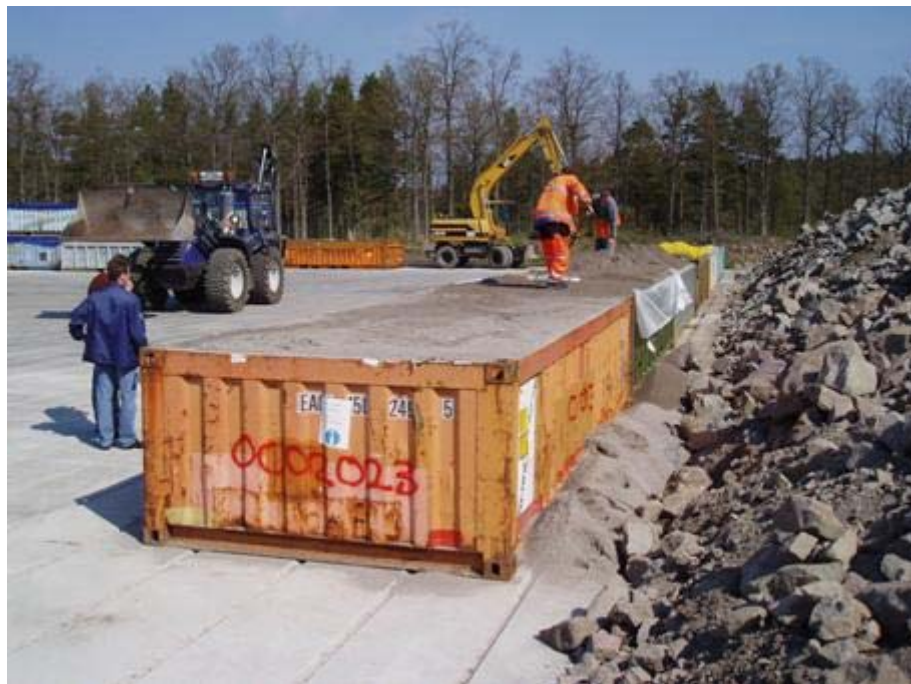
3.10 pav. Konteinerių užpildymas sorbuojančia/užpildo medžiaga
