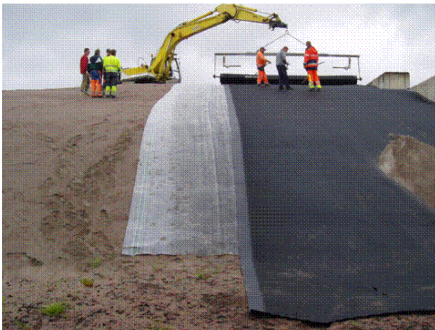
3.14 pav. Bentonito kilimo ir HDPE sluoksnio klojimas
