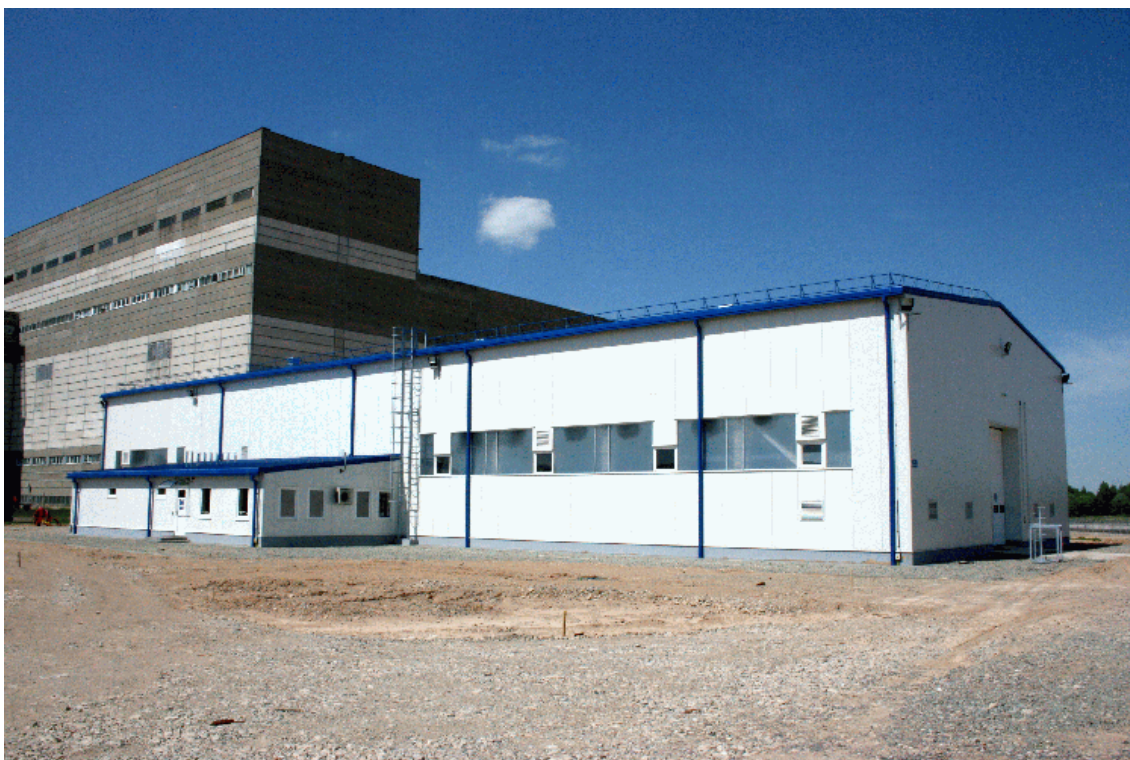
4-6 pav. Medžiagų radioaktyvumo (nebkontroliuojamų lygių) matavimo įrangos kompleksas
