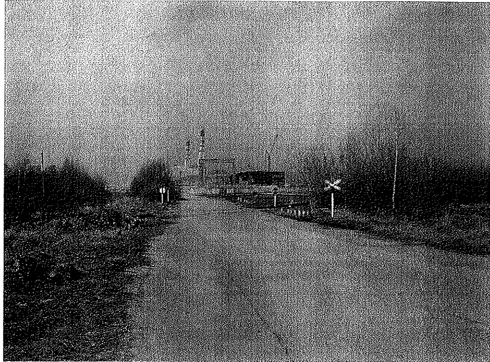
1 paveikslas. Vaizdas iš rytų "IAE 1 ir 2 blokus bei nebaigt" statyti (ardom") 3 blok"
