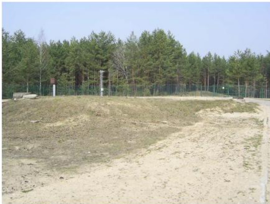
2-4 pav. Skystųjų radioaktyviųjų atliekų rezervuaro vaizdas: kairėje – pagrindinė anga patekti į rezervuarą, dešinėje – speciali anga skystųjų atliekų supylimui [5]
