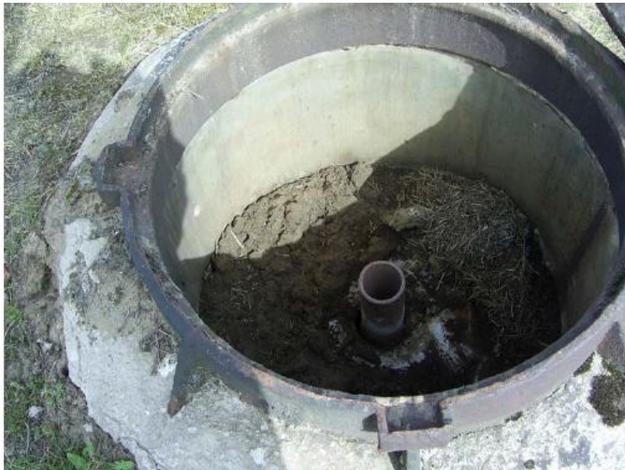
2-5 pav. Skystųjų radioaktyviųjų atliekų rezervuaro specialioji anga skirta pilti radioaktyviosioms atliekoms [5]
