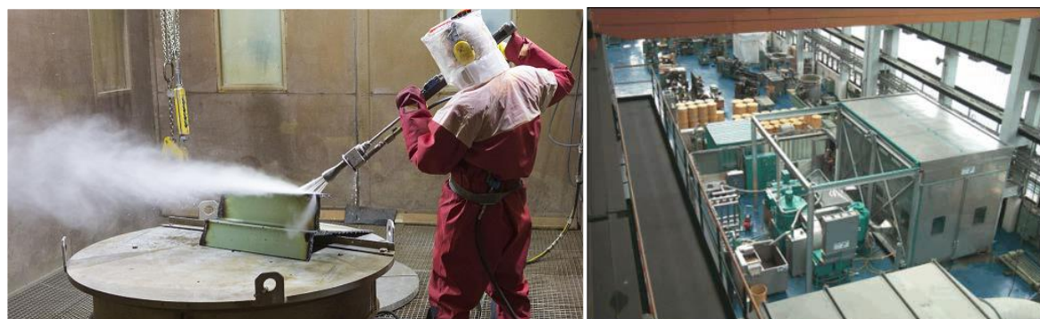
12.4-12 pav. Drėgnoji (šlapioji) dezaktyvacija (vandens srovės įrenginiai);
