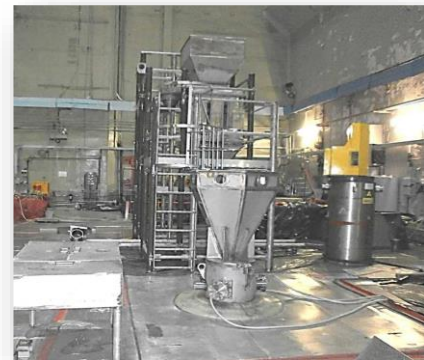
12.3-3 pav. RBMK-1500 reaktoriaus išmontavimo zonos. Grafito išėmimo įrenginys.
