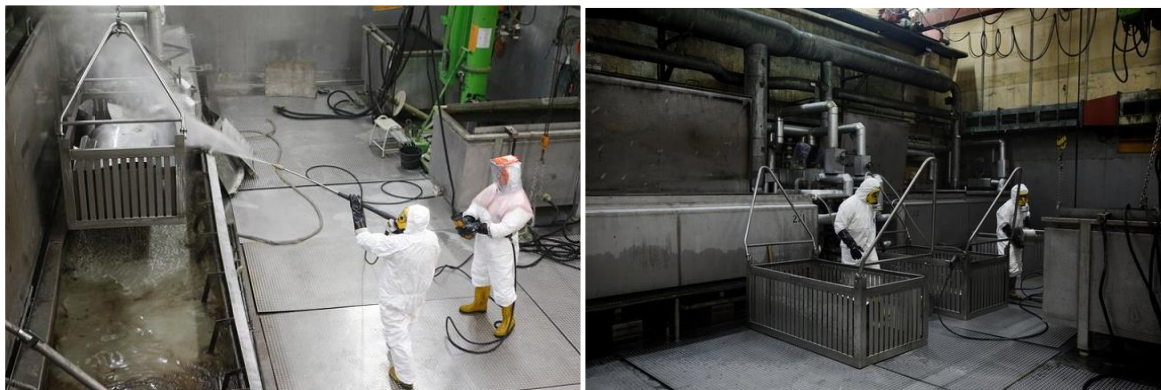
12.4-13 pav. Cheminė dezaktyvacija (ortofosforo rūgštimi);
