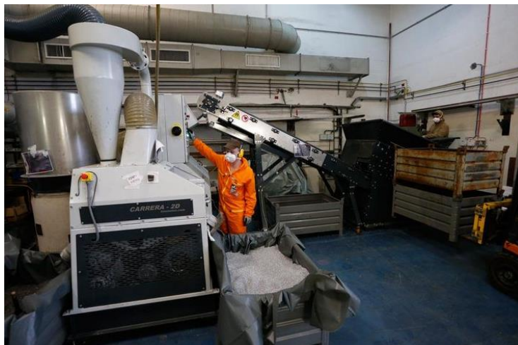
12.4-18 pav. Kabelių tvarkymas, izoliacijos pašalinimas ir tolesnis susmulkinimas.
