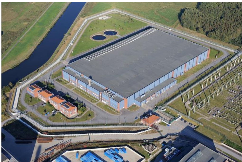
12.4-9 pav. Bendras laikinos buferinės saugyklos vaizdas (Interim Storage North)
