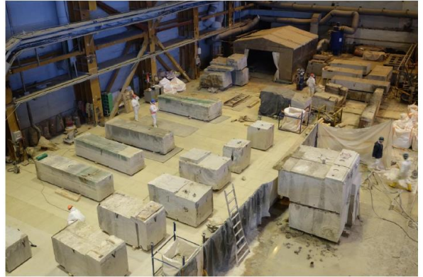
Išmontuotinas G2 betono smulkinimo baras
