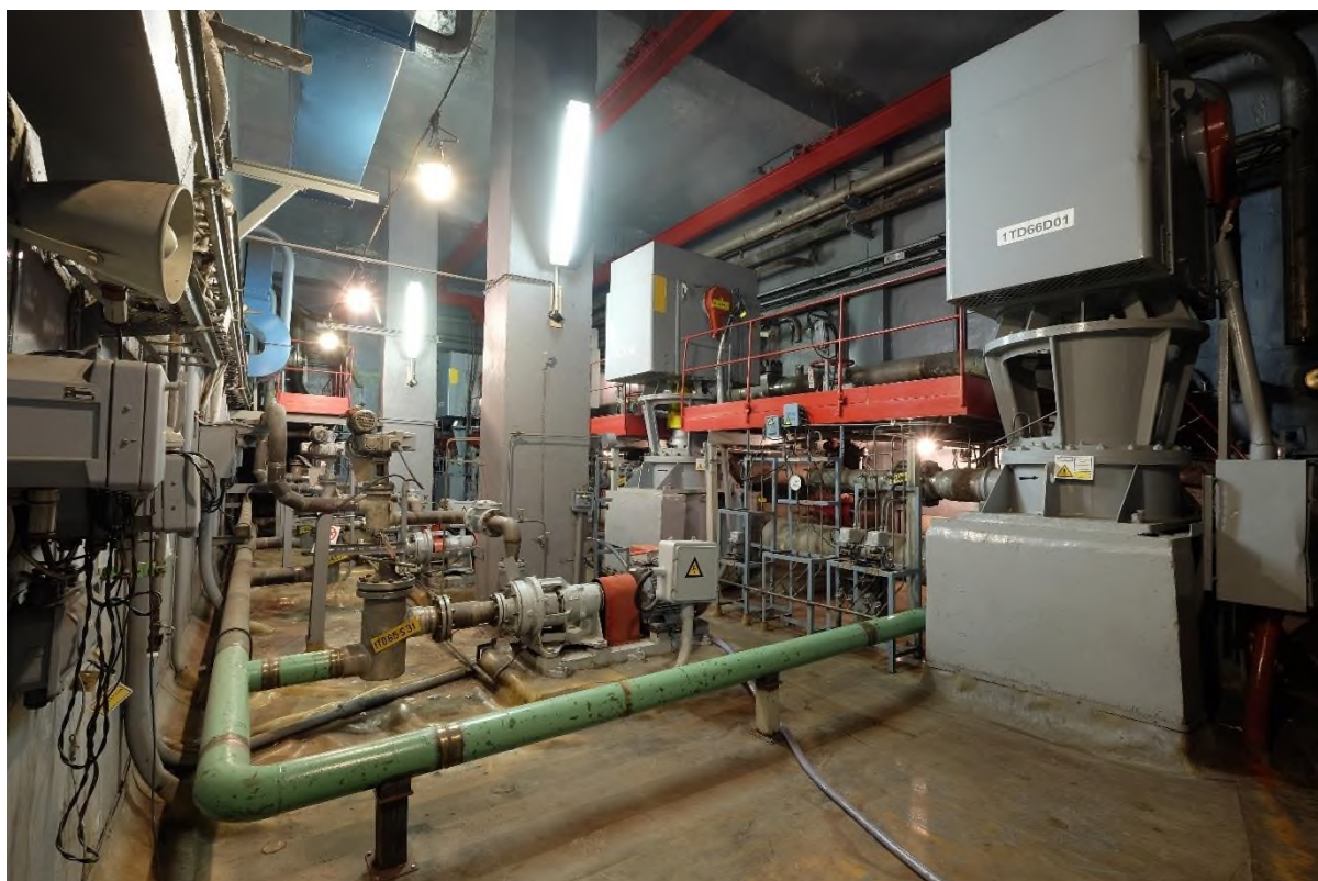
Pav. 2.1-4 „Švaraus“ MDV siurblių įranga 014 pat.
