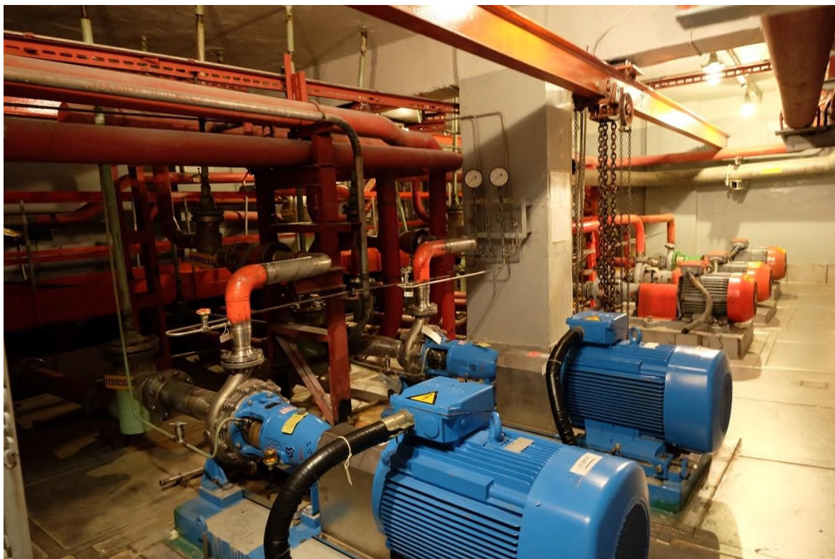
Pav. 2.1-3 „Užterštojo“ MDV siurblių įranga 012 pat.
